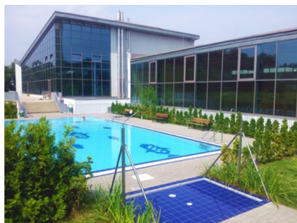
Slaný plavecký bazén v Hloubětíně, zdroj: bazenhloubetin.cz
